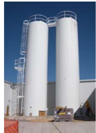
Los silos de almacenamiento amplios para cargas en camiones cisterna
