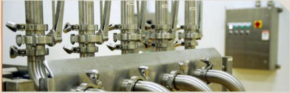
> Distribución con paneles de flujo y válvulas de mariposa.
